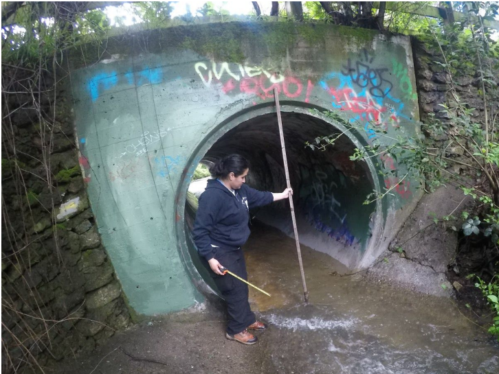
Photo 3: El Centro Culvert
